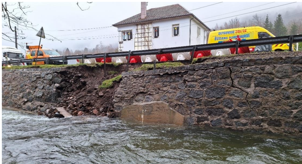
Figure 3 - Vue de l'effondrement du mur au PR 34+210
